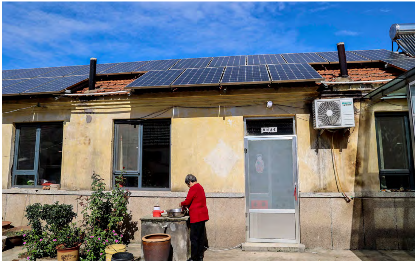
山东省青岛市的一栋房子屋顶安装了太阳能发电板。
